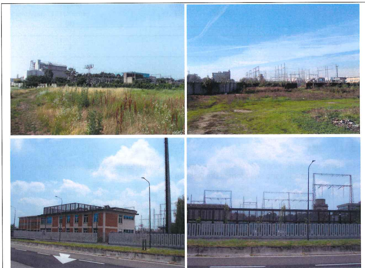
Figura 3.1: Stazione Elettrica vista dall'area di progetto (in alto) e da Viale Rubattino (in basso)
