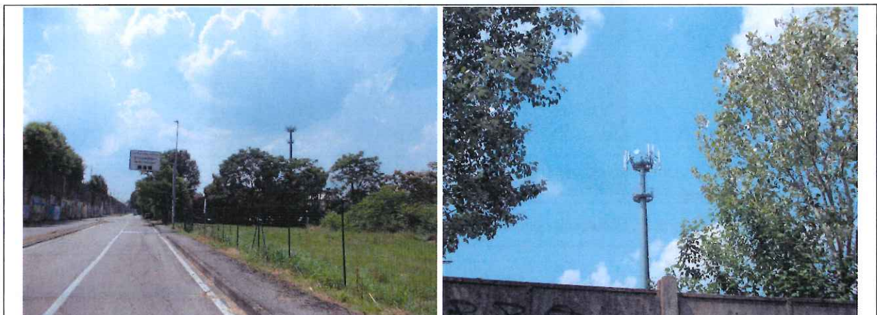
Figura 3.14: Documentazione fotografica della stazione radiobase Via Lazio
