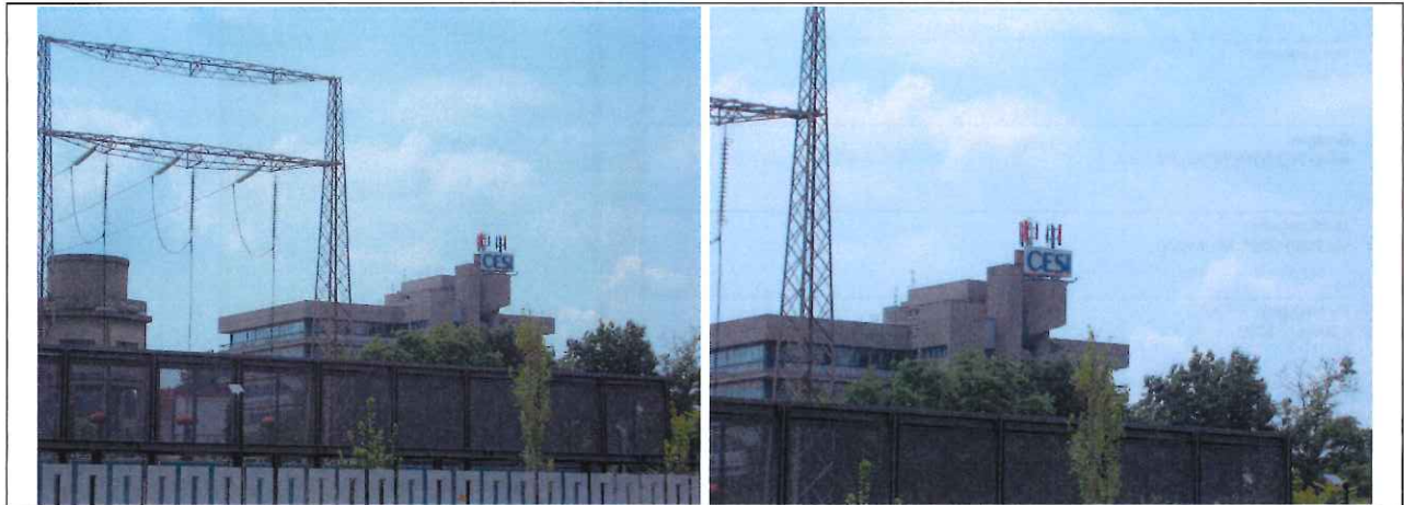
Figura 3.11: Documentazione fotografica della stazione radiobase su sede CESI
