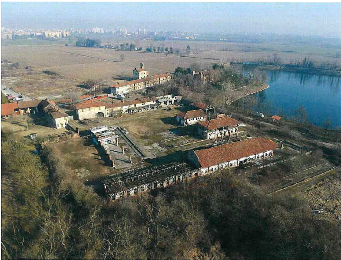
Vista sud: stato di fatto
