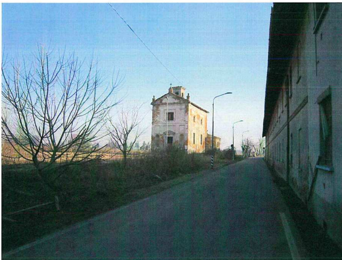
Vista dello stato di fatto di via Macconago
