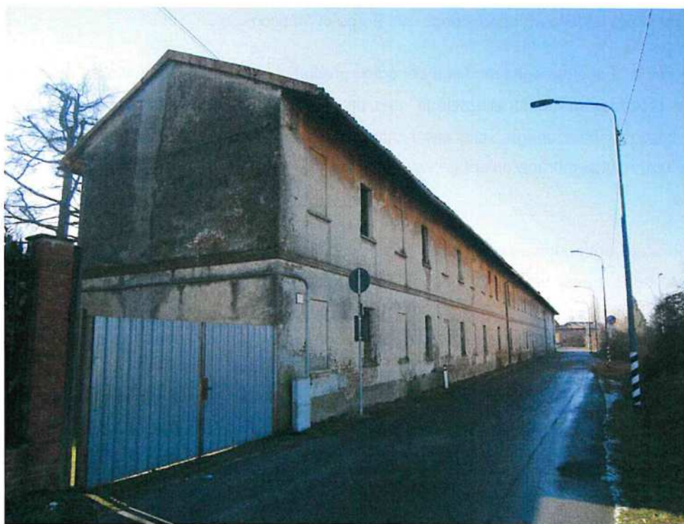
Vista esterna edificio salariati
