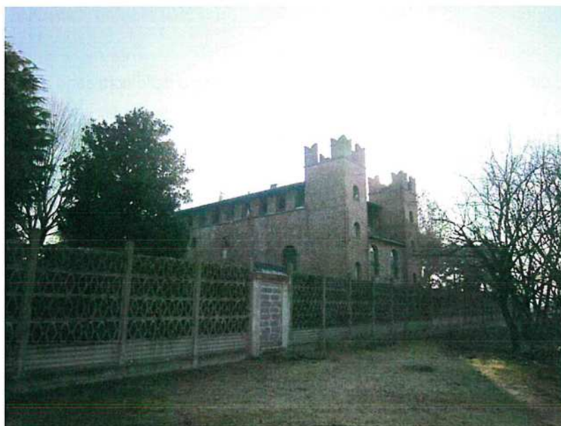
Veduta della facciata verso l'area oggetto di intervento
