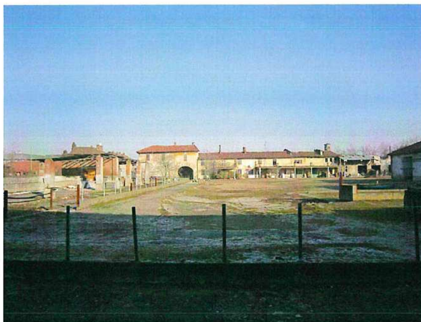
Vista interna edificio padronale
