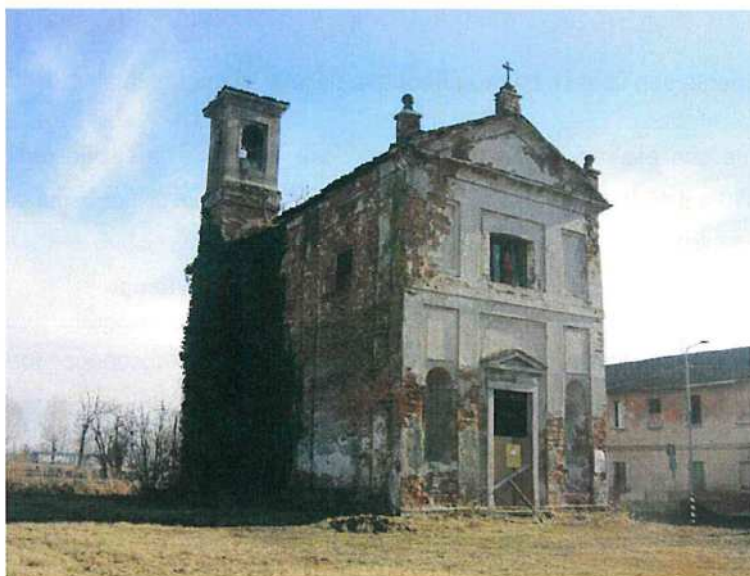
Particolare della facciata principale
