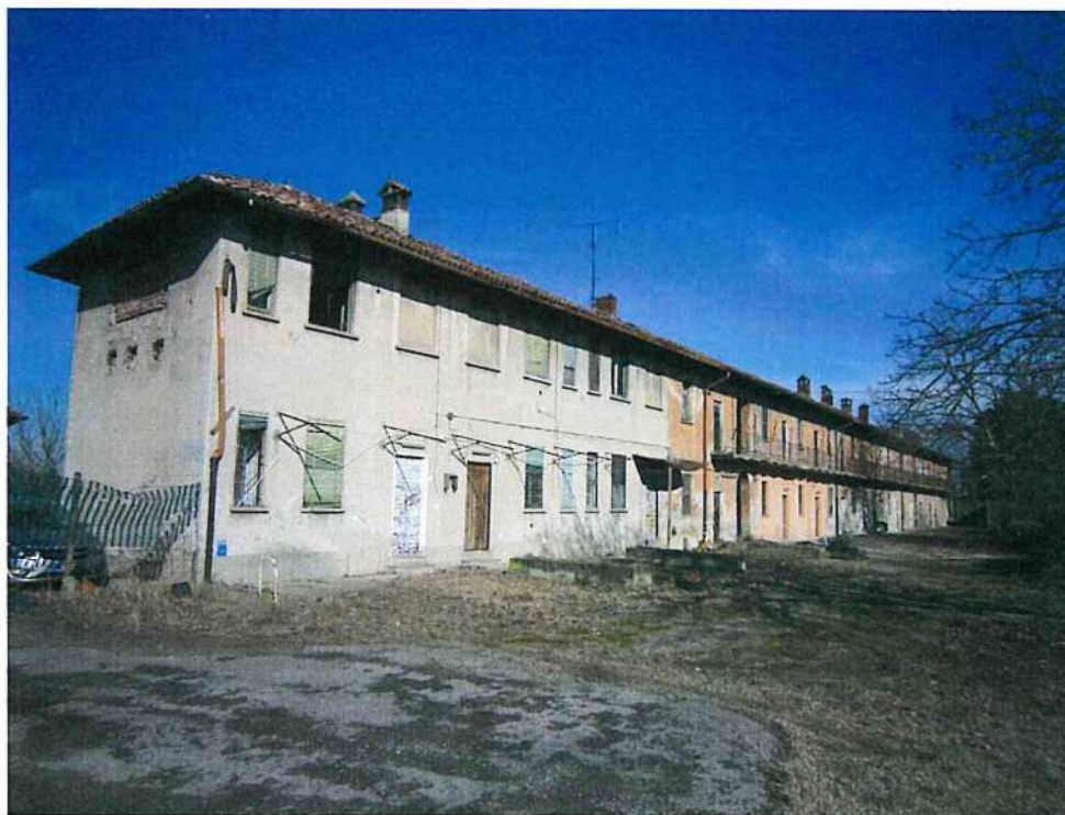
Vista interna edificio salariati
