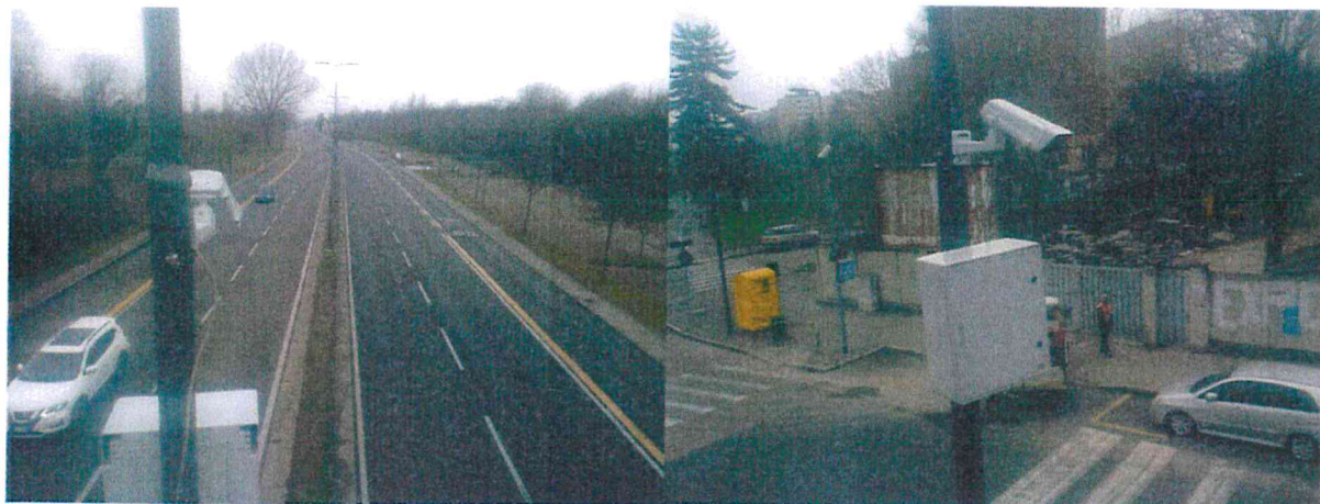
Figura 5.5: Esempi applicativi di videocamere installate mediante cestello
