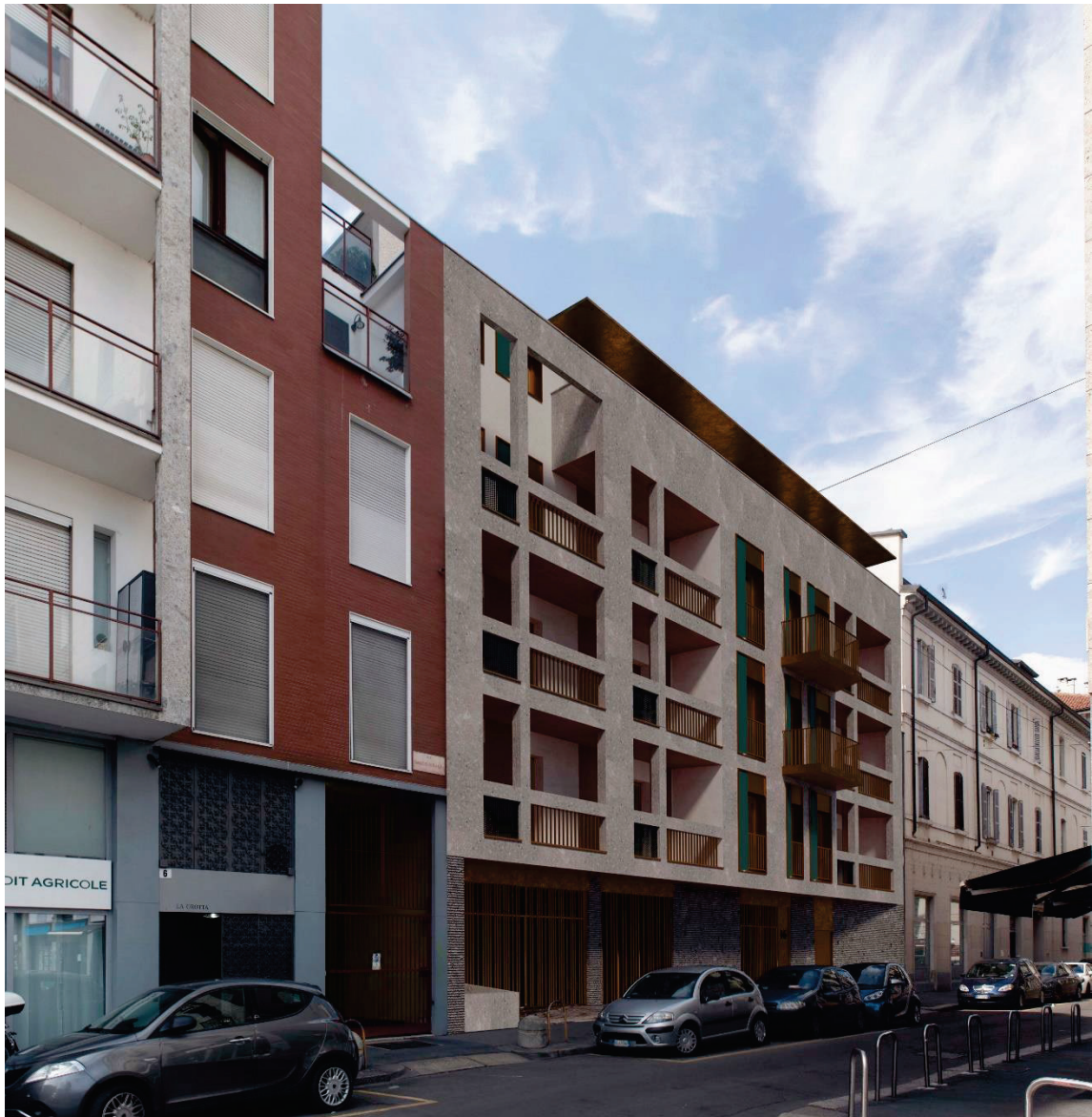
Foto-inserimento del progetto (vista del prospetto su via Crespi da Piazza Cantore)
