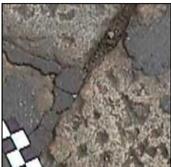
Figura 13: Asportazione di sigillante dai giunti
