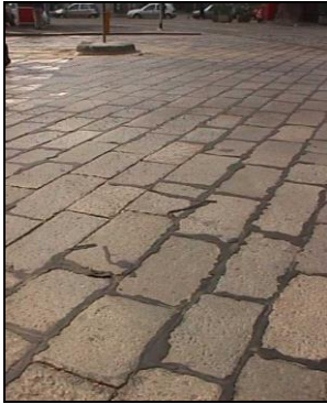
Figura 14: Spandimento di legante sul massello
