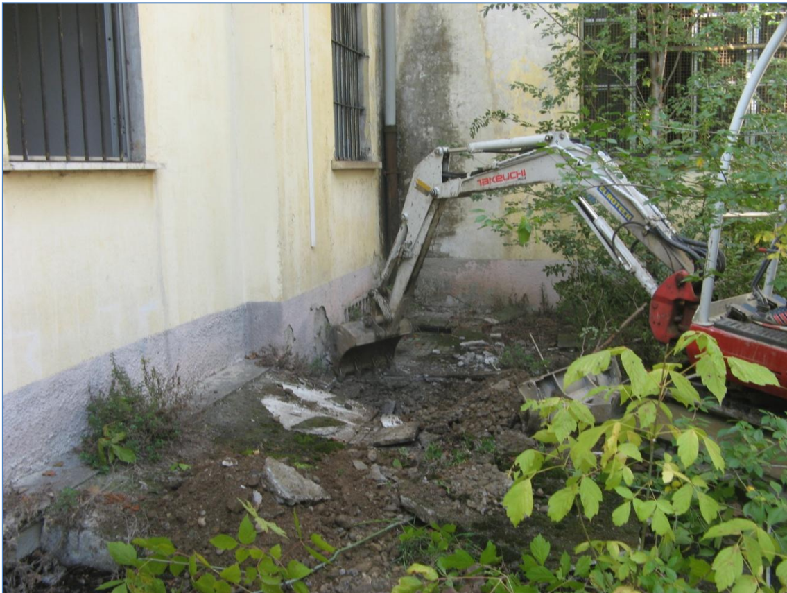
Panoramica del punto di ispezione.
