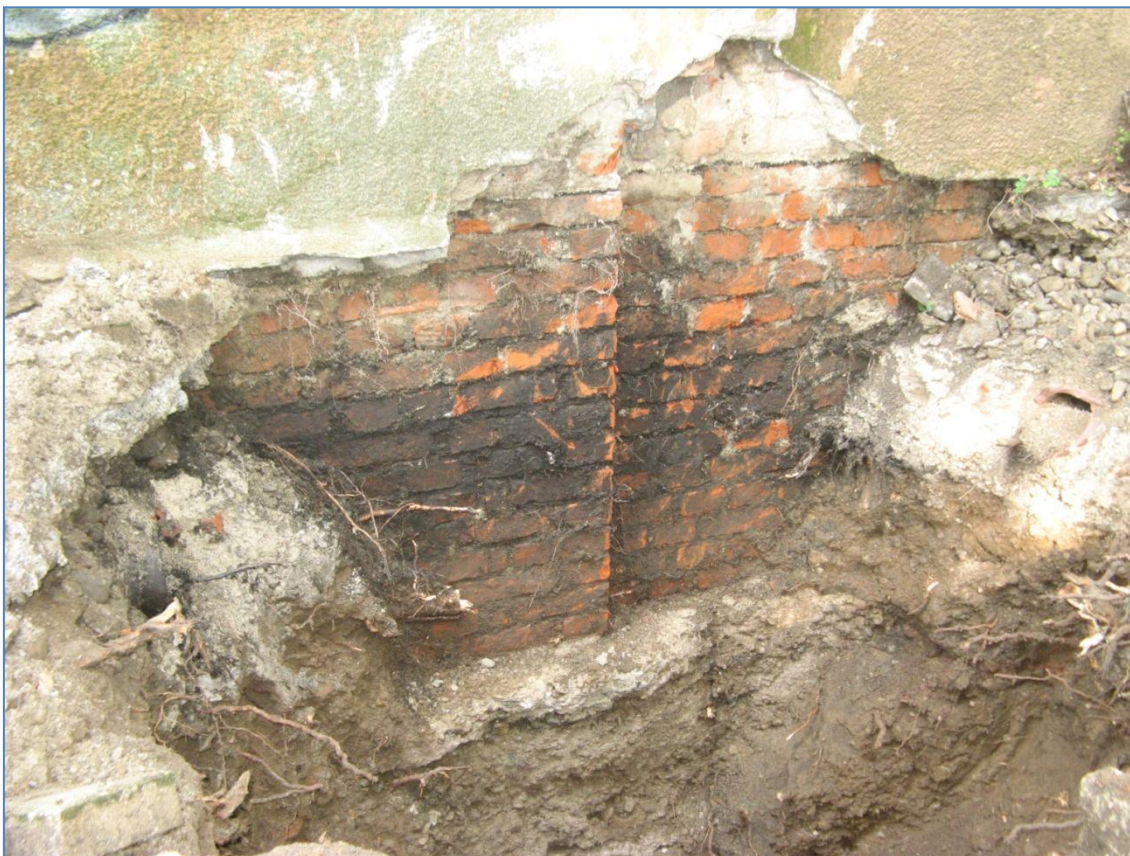
Panoramica del punto di ispezione.
