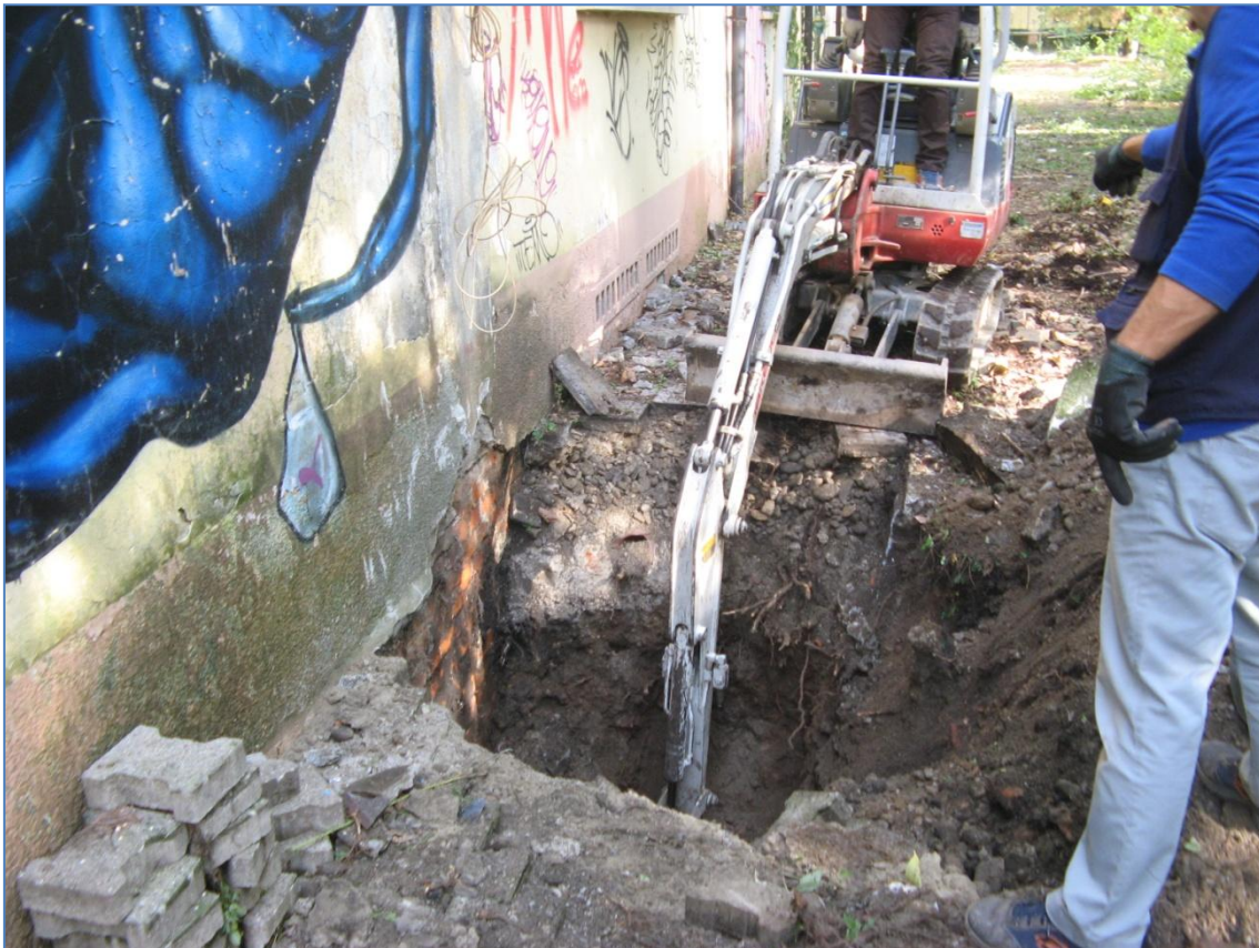
Panoramica del punto di ispezione.
