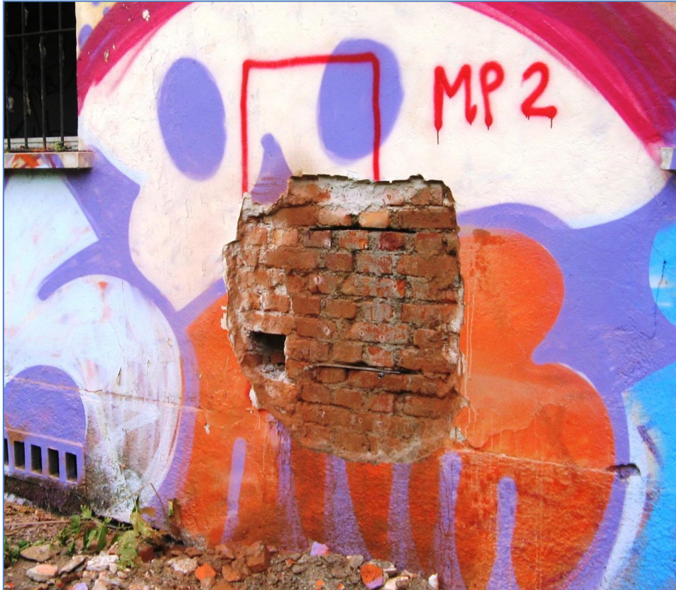
Panoramica della zona di prova dopo il secondo taglio.
