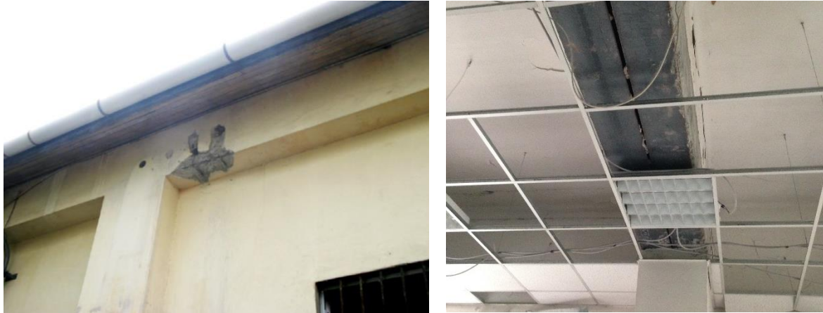
Figura 7 – Trave in c.a. e in acciaio
