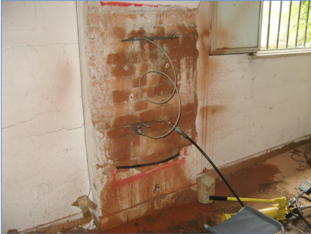
Il paramento murario durante la prova con martinetto piatto doppio.
