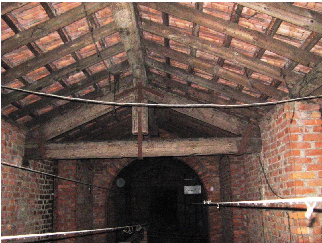
INDAGINE RESISTOGRAFICA L6 – CATENA CAPRIATA
