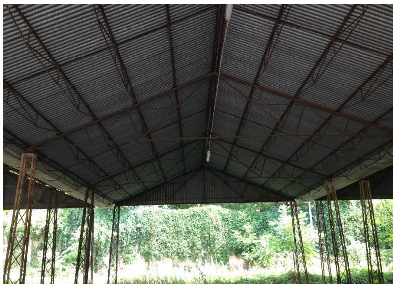
Figura 3 – modulo della tettoia metallica a nord
