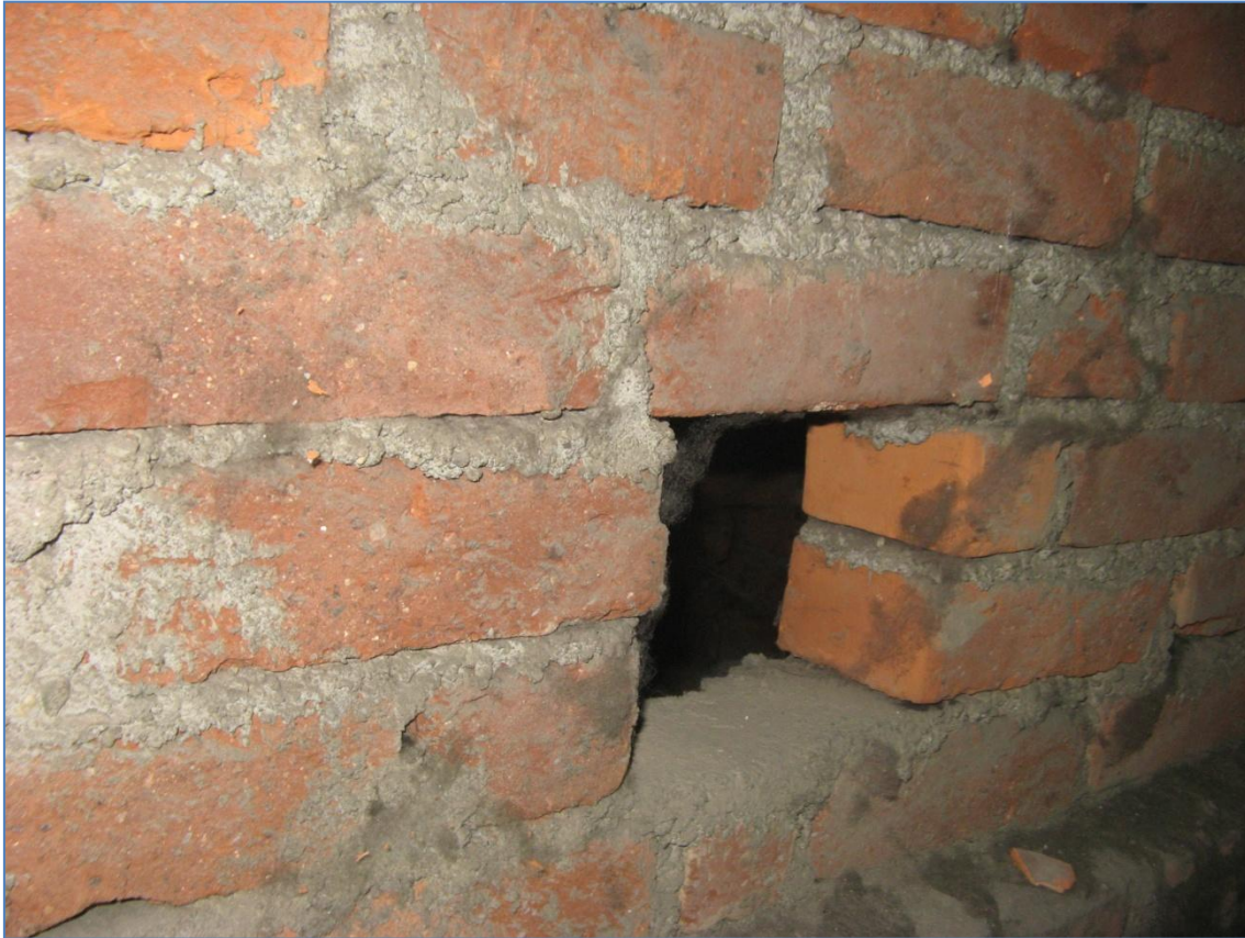
Nel muretto sono previste aperture per l'aerazione del vespaio.
