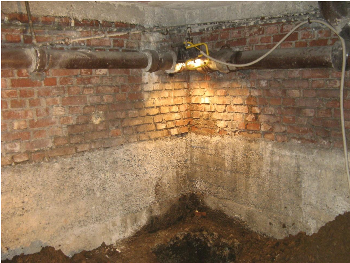
Panoramica dello scavo aderente alla muratura perimetrale interna al fabbricato.
