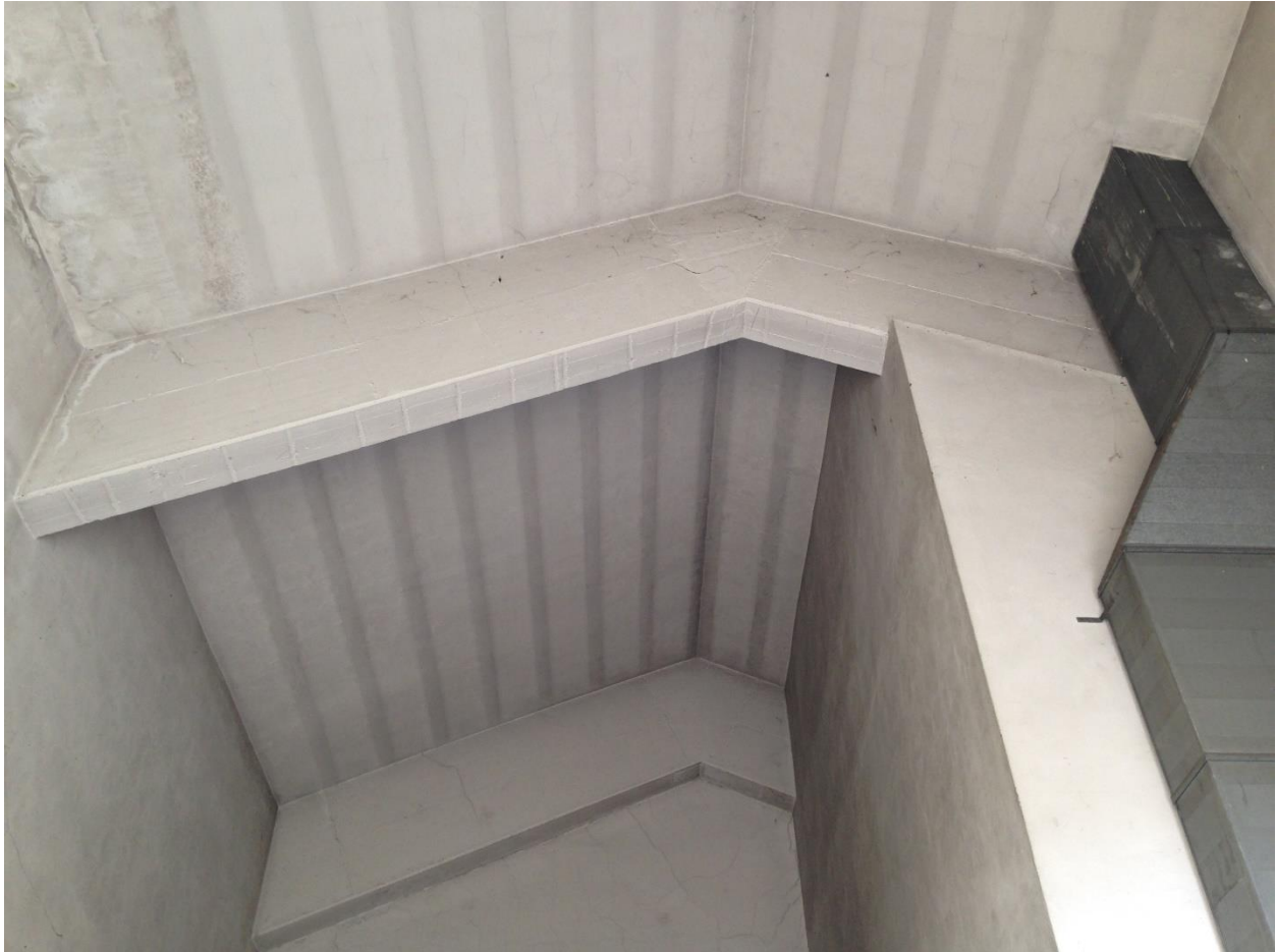
Figura 6 – telai in calcestruzzo e solai in laterocemento
