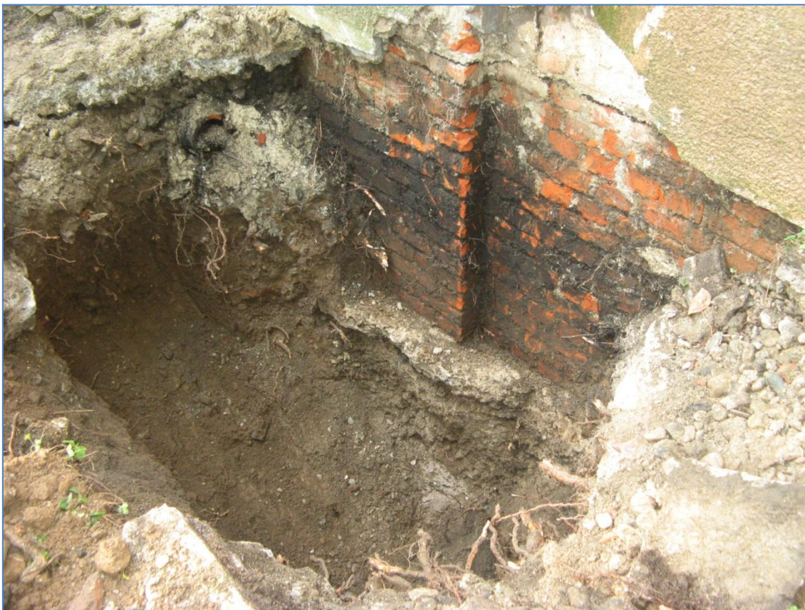
Panoramica del punto di ispezione.
