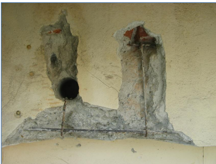
rilievo armature mediante asportazione controllata del copriferro (esterno fabbricato)
