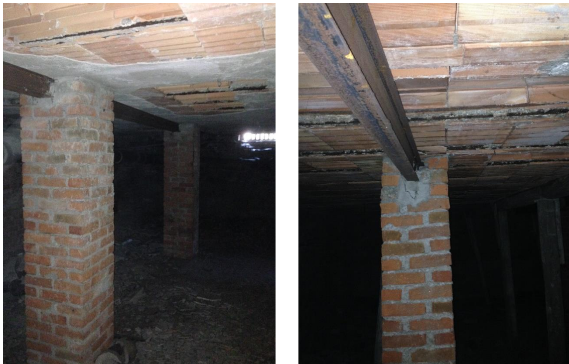
Figura 8 – Intervento di rinforzo dei solai al piano interrato
