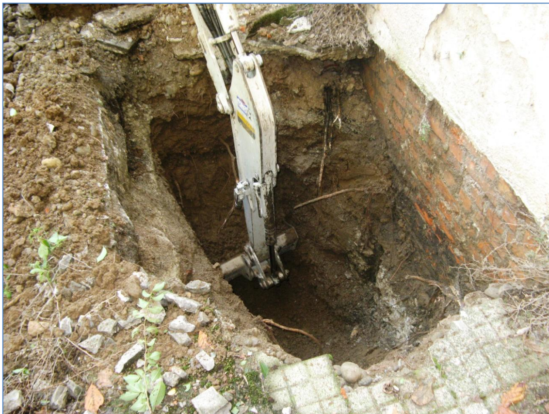
Particolare del fondo scavo alla quota dell'imposta della fondazione.
