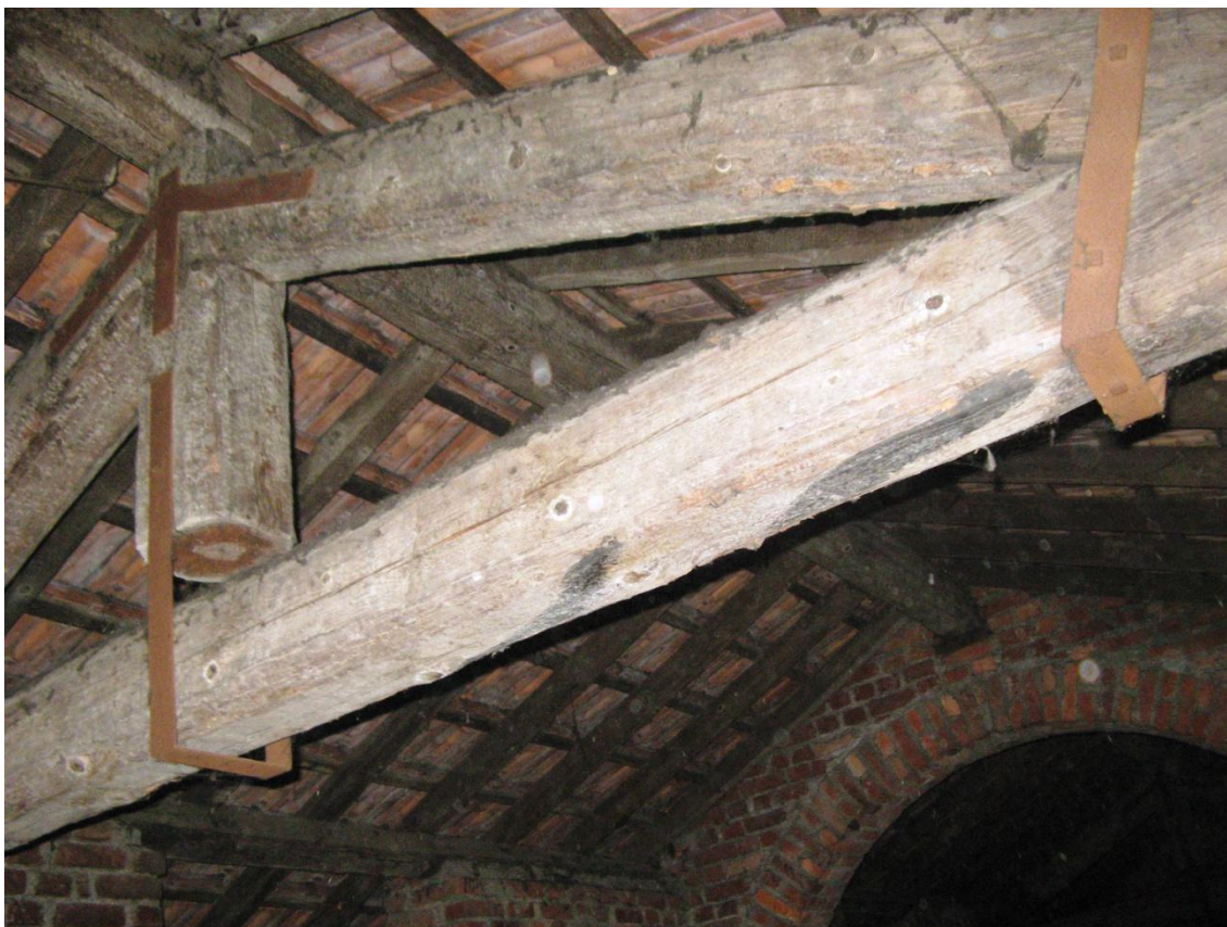
INDAGINE RESISTOGRAFICA L2 – CATENA CAPRIATA
