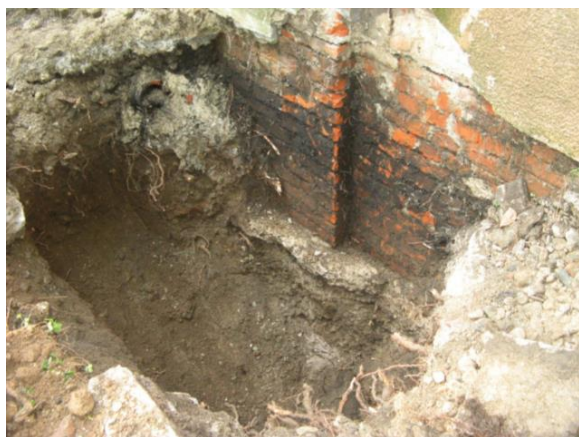
Figura 11 – Fondazioni in c.a. di pezzatura grossolana
