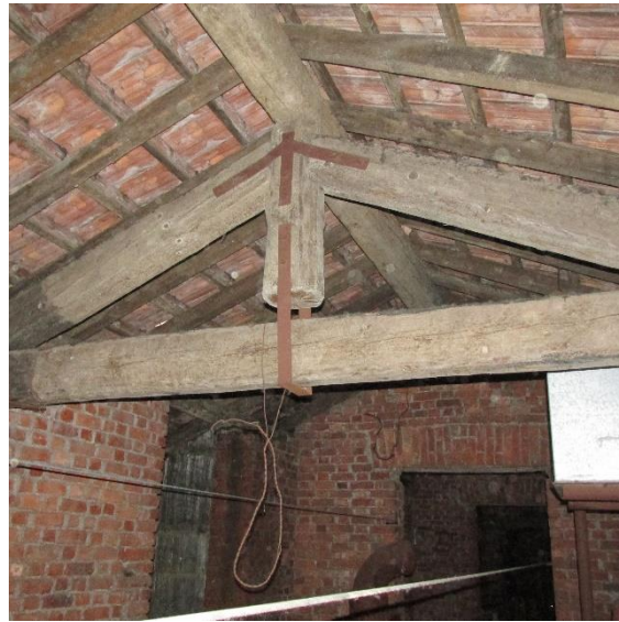
Figura 9 – Copertura con arcarecci su muro o su capriata alla palladiana
