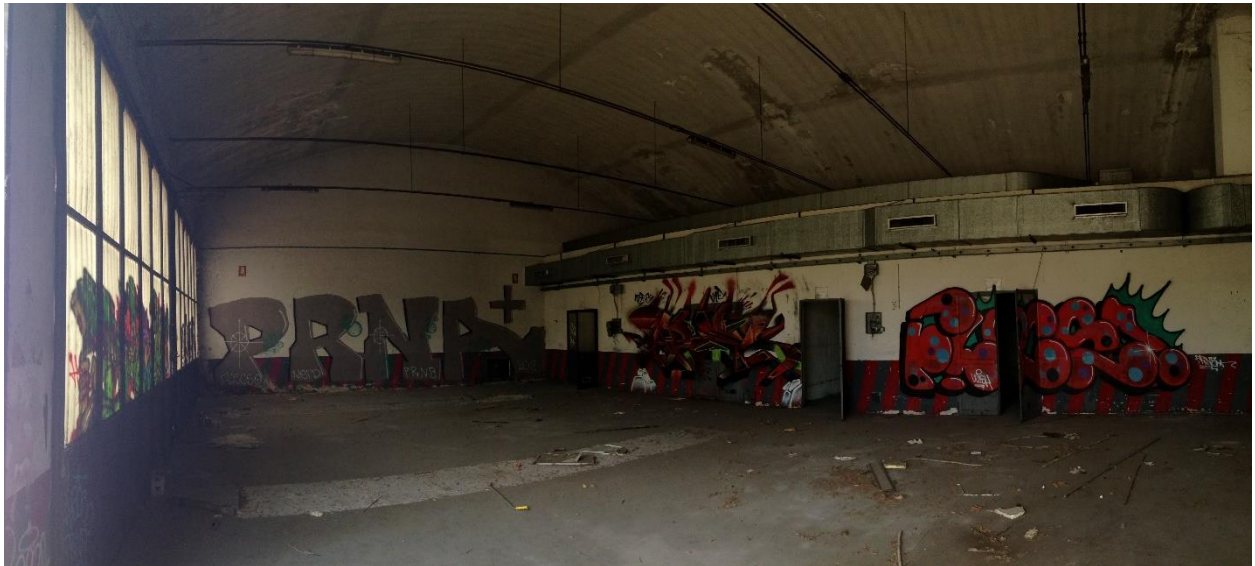
Figura 5 – struttura a volta con catena metallica
